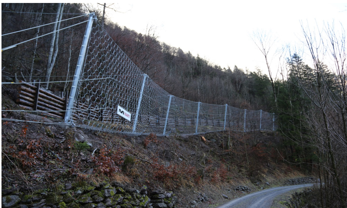
Eine 85m lange Netzreihe oberhalb der Sernftalstrasse (Kantonsstrasse) und zwei Waldstrassen.
